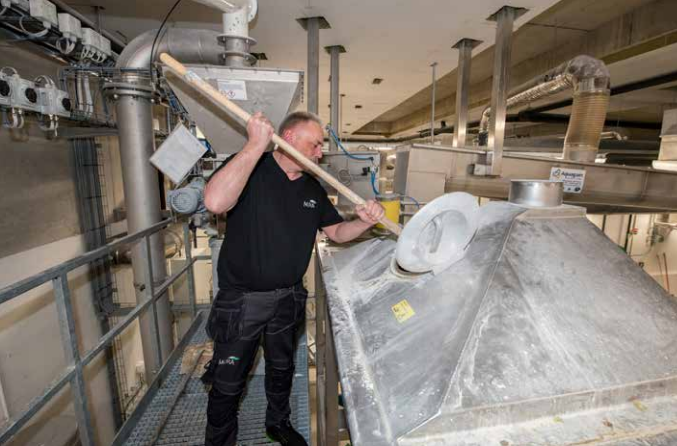
Rengjøring av slam/kalkmikser.
