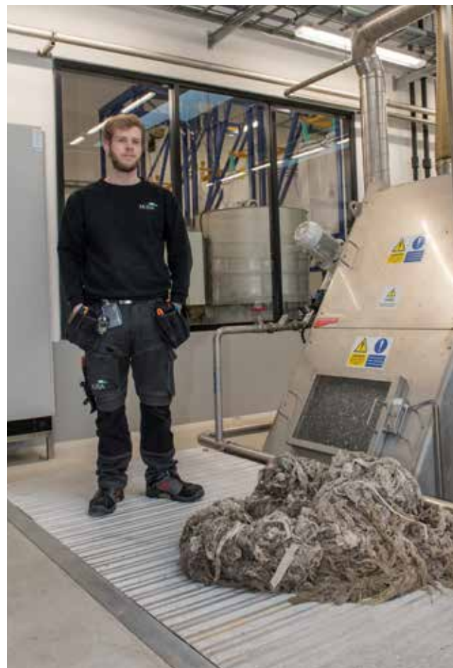
Filler og avfall som kastes i avløpet tas ut av avløpsristene til Tangen RA.
