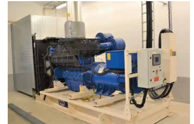
Nødstrømsagregat for beredskap.
